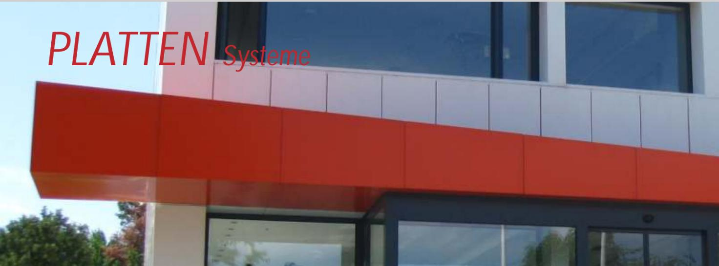
Diese Gruppe umfasst Aluminium-Unterbausysteme mit Belägen aus flach geschnittenen Platten, die mit sichtbaren oder nicht sichtbaren mechanischen Verbindungen und Verbindungen durch chemische Mittel, bzw. Kleben, mit dem Unterbau verbunden wird. Diese Gruppe umfasst ein breites Spektrum an Fassadenmaterialien und bietet folgende Systeme an: RIVET, TACK, HIDE, STONE, CONTINUAL.
