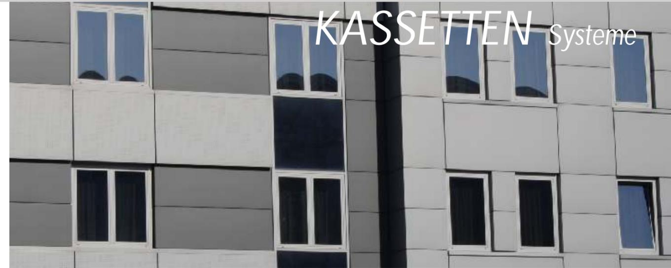
Diese Gruppe umfasst fünf Aluminium-Unterbausysteme, wo der Belag aus Kassetten besteht, die durch Ausschneiden, Nutenfräsen, Biegen geformt werden, mit entsprechender Tiefe und ihre mechanische Verbindung mit dem Unterbau ist meistens vollkommen unsichtbar. Die Materialien, welche bei dieser Gruppe als Belag verwendet werden, sind plastischer und ermöglichen zusätzliche Bearbeitung. In dieser Gruppe befinden sich folgende Systeme: *BOX, SLIDER, BOLT, GASKET, FIT*.
